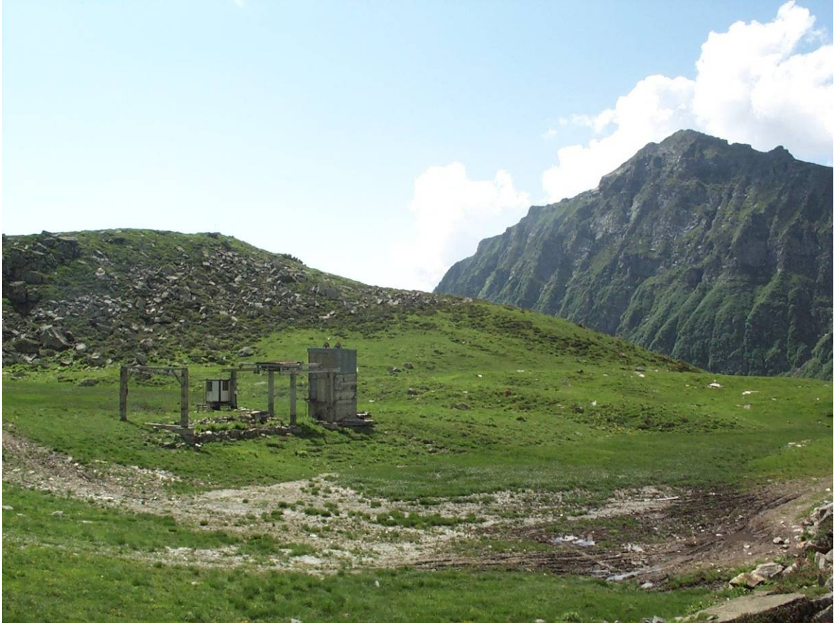
Fig. 7. Vista della vecchia stazione di partenza dell'impianto di risalita ormai smantellato.
