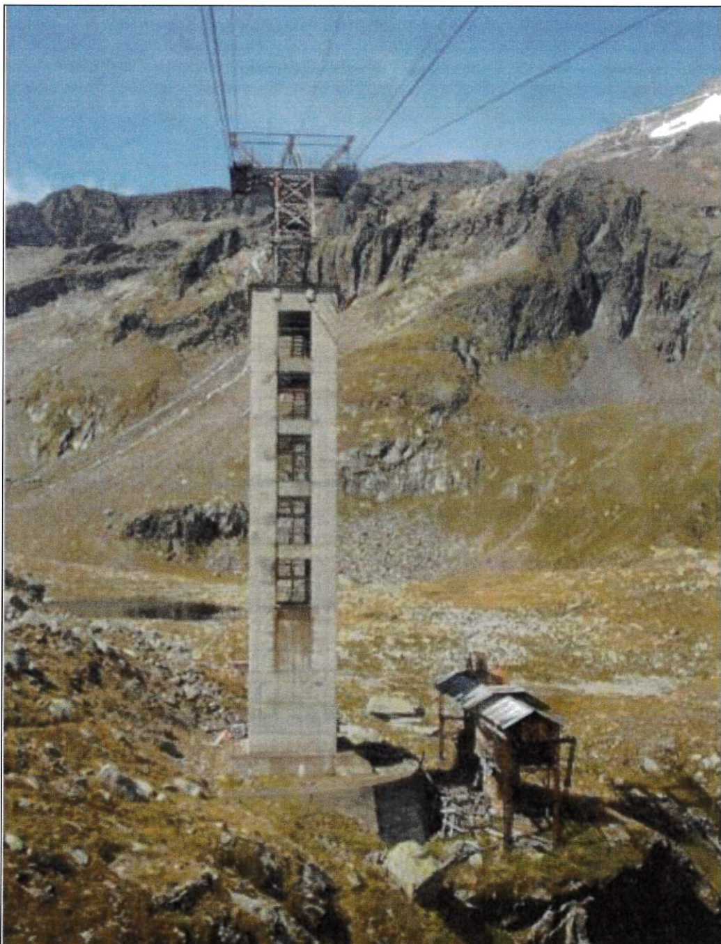
Sostegno 2 – Vista frontale, da valle – Le parti di prevista demolizione sono costituite dalle strutture funiviarie di sommità e dalla teleferica di servizio, alla base.
