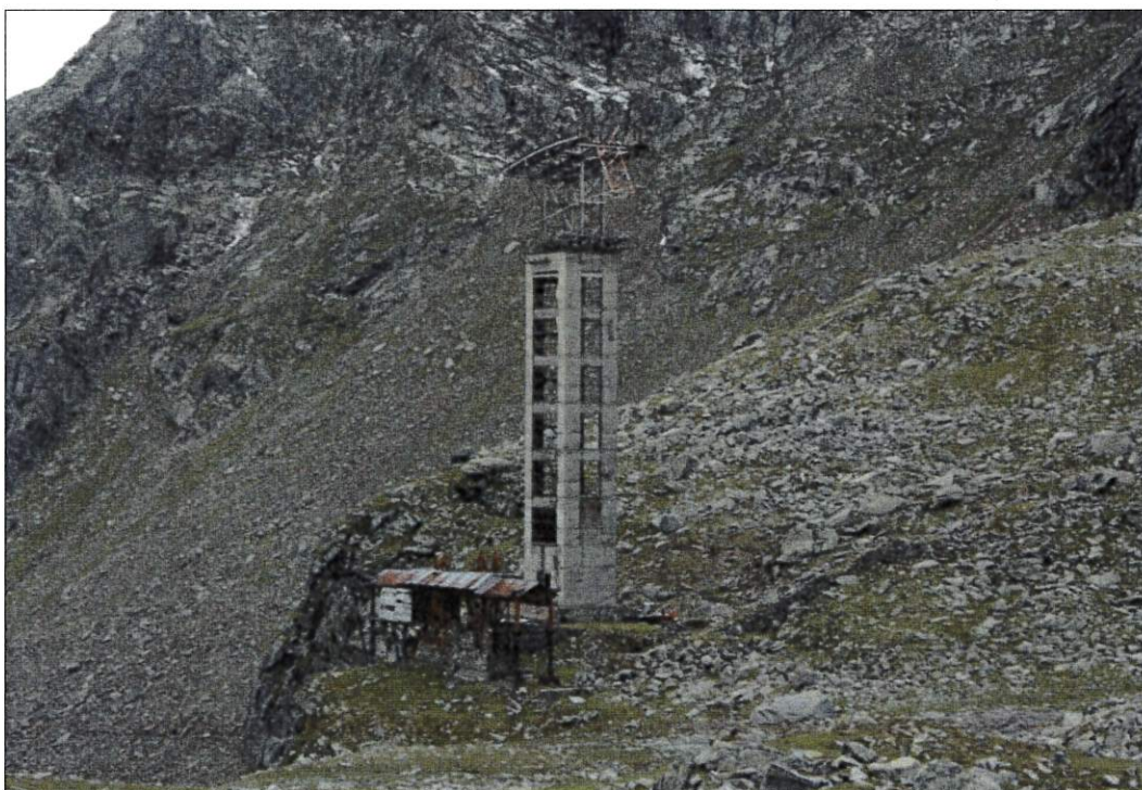
Sostegno 2 - Vista da nord-est
