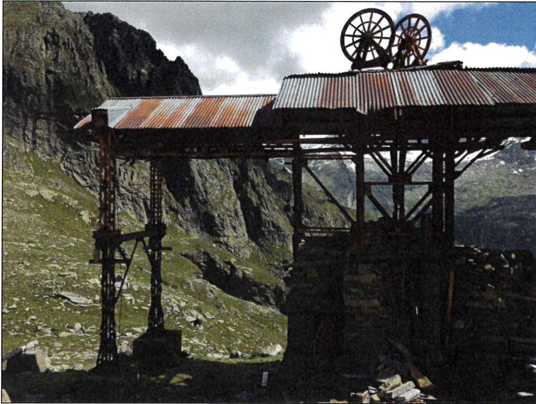
Sostegno 2 – Dettaglio della teleferica di prevista demolizione
