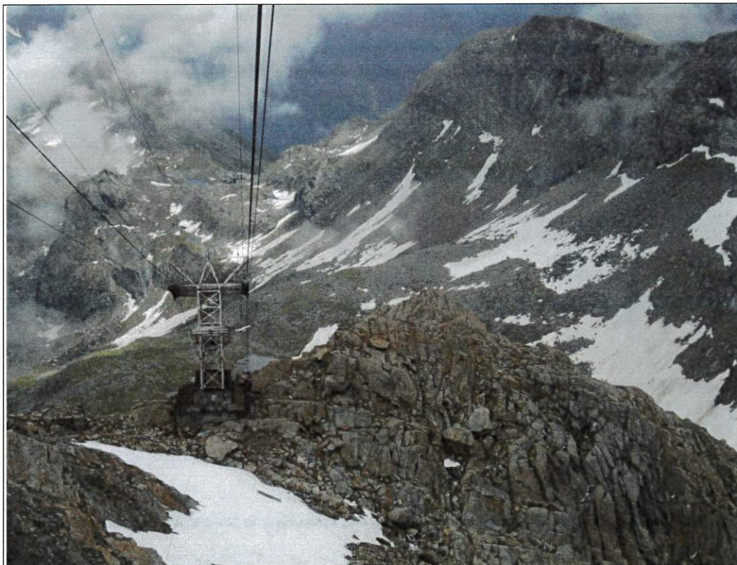
Sostegno 3 - Vista da monte
