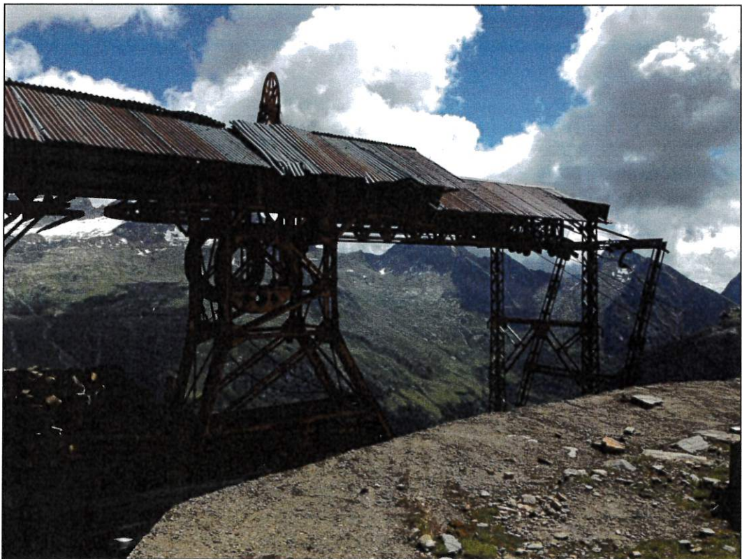
Sostegno 2 – Dettaglio della teleferica di prevista demolizione
