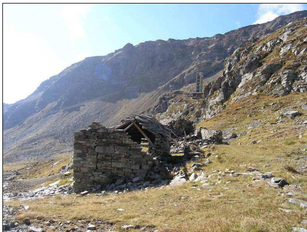
Figura 6 – Vista sullo sfondo del pendio del tracciolino
