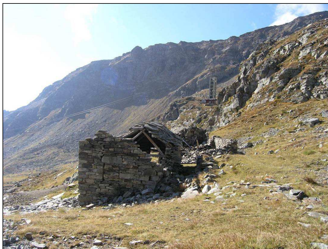
Foto 3.2/4 – vista sullo sfondo del pendio interessato dal tracciolino
