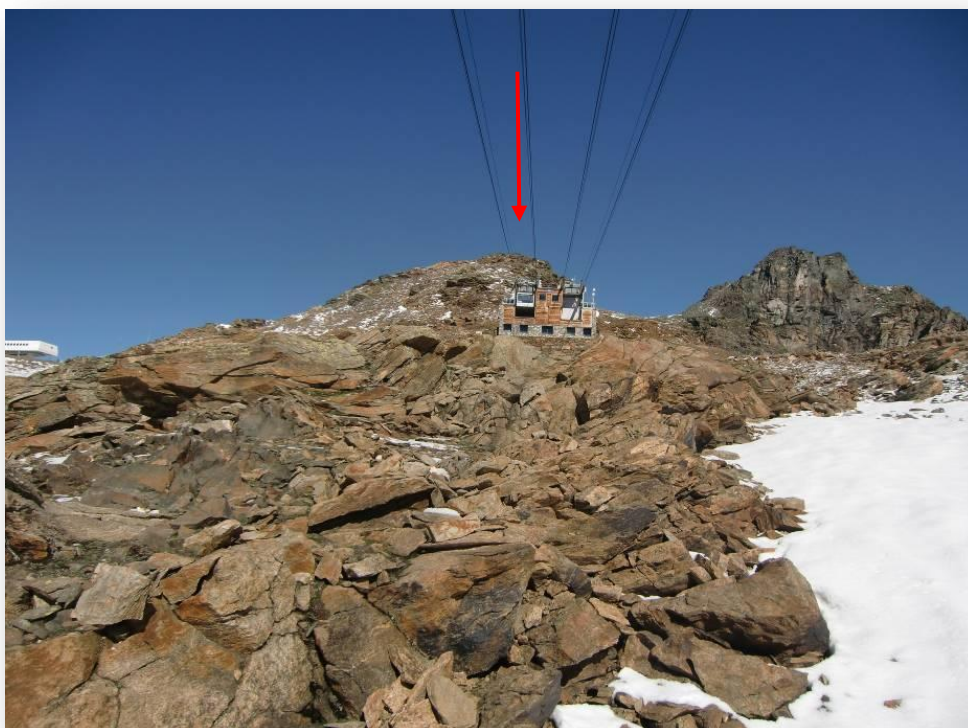
Figura 4.1/7 la stazione di monte della funivia esistente vista da valle, nello sfondo sono visibili le prime pendici del rilievo pendici in corrispondenza del quale, in posizione arretrata, sarà realizzata la stazione di monte dell'impianto in progetto
