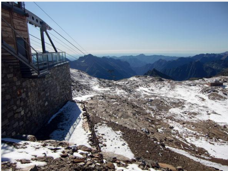
Figura 4.1/6 il corridoio d'intervento visto dalla stazione di monte dell'impianto esistente
