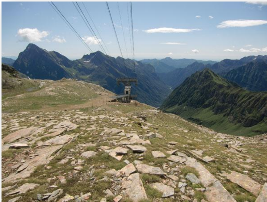
Figura 4.1/4: vista in direzione della stazione intermedia “Cimalegna” dell’impianto esistente “Pianalunga-Cimalegna-Passo dei Salati” in prossimità della quale verrà realizzata la stazione di valle del nuovo impianto; il proposto impianto di risalita si colloca, nella foto, sulla destra dell’impianto esistente
